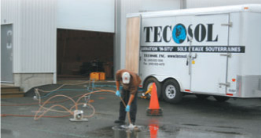
Application du traitement Soltec in-situ à l'aide de puits d'injection sous le bâtiment
